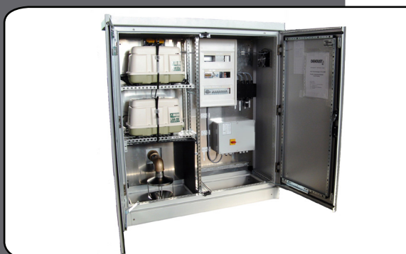
Schakelkast met systeembesturing en beluchtingspompen.
