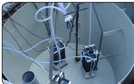
3 BMT modules in ondergrondse tank.
