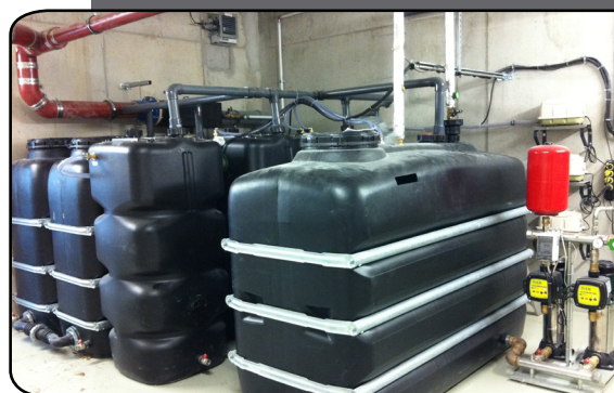
GEP grijswatersysteem GWM 6.000 in een pand in Darmstadt. 500 werknemers.
